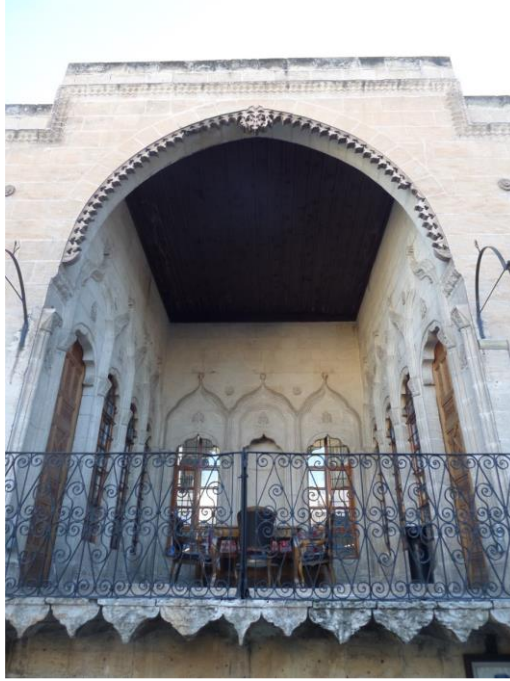
Şekil 19 Hacı Hafızlar Evi'nde Eyvan (Şanlıurfa Kültür Varlıkları)
