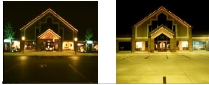
Şekil 17 Asfalt ve beton gece görüş güvenliği
