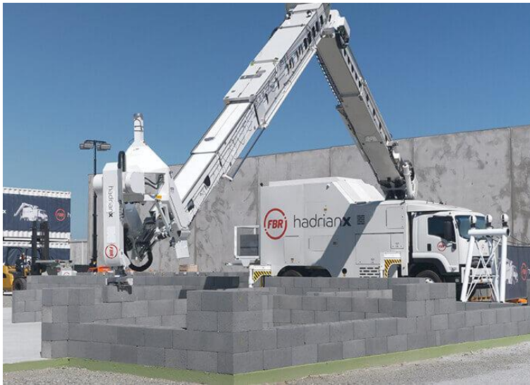
Şekil 30 Hadrian X ile Duvar Örme İşlemi (Redshift.autodesk.com.tr, 2019)
