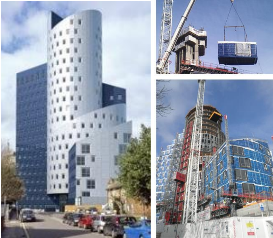
Şekil 24 Sol: Victoria Hall Öğrenci Yurdu, Sağ: Yapının İnşası (Modular.org, t.y)
