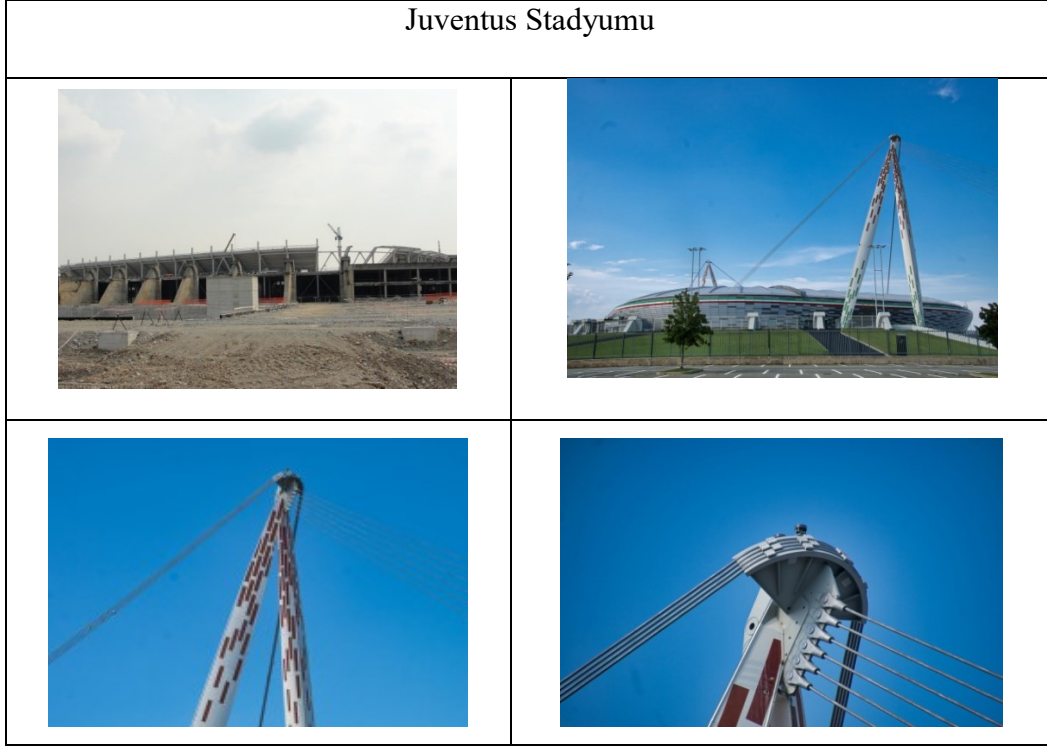
Şekil 19 Juventus Stadyumu (Allianz Stadyumu – İtalya) İnşa Aşaması, Görünüşü ve Kablo Sistem Detay Fotoğrafları [structurae.net, 2022]
