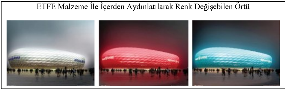
Şekil 61 Allianz Arena'nın Renk Değiştirebilen Örtü Sistemi (Twardowski, 2018)
