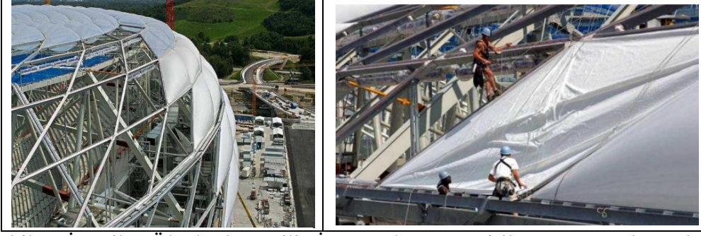
Şekil 59 İstenilen Ölçülerde Kesilip İnşaat Alanına Getirilen ETFE Malzemelerin Montajı (Gonçalves, 2017)
