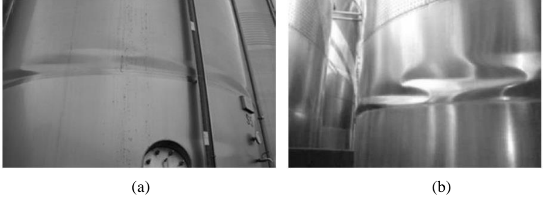
Şekil 13. Elmas şeklindeki burkulma
