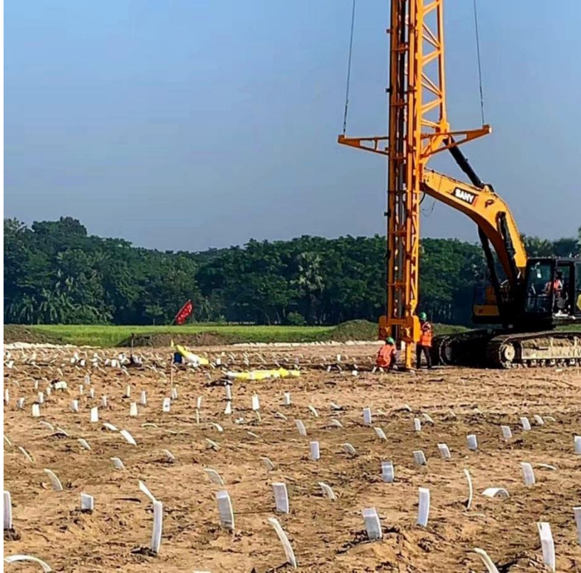
Şekil 8. Dikey fitil drenaj
