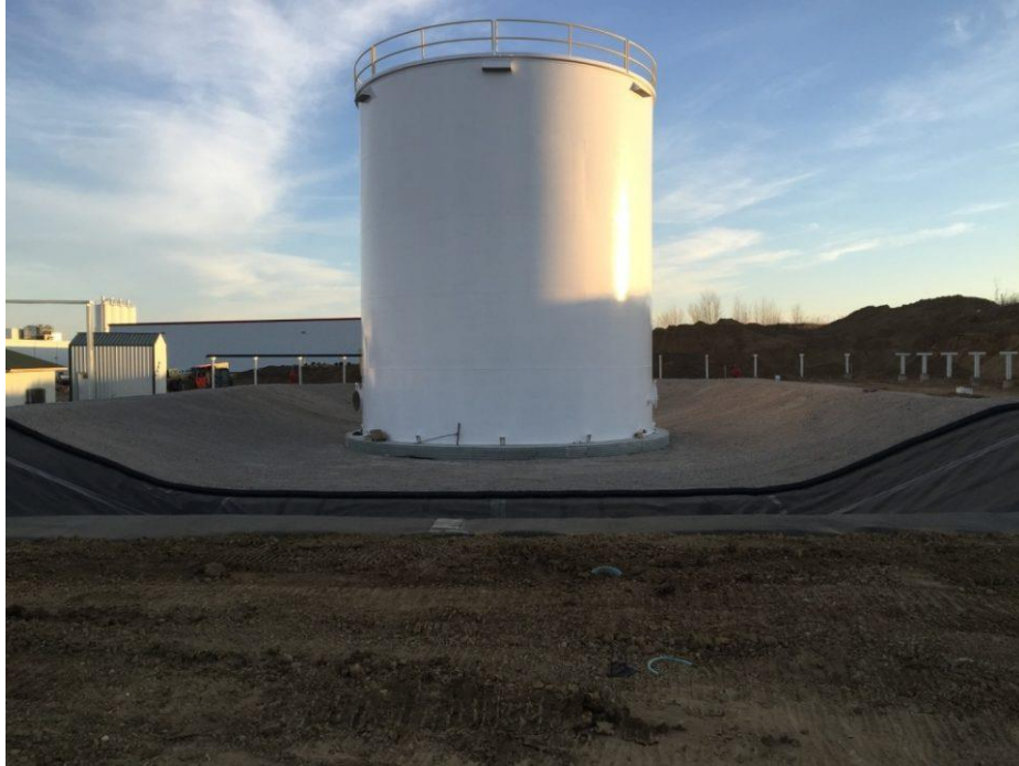
Şekil 10. Tank etrafındaki set duvar
