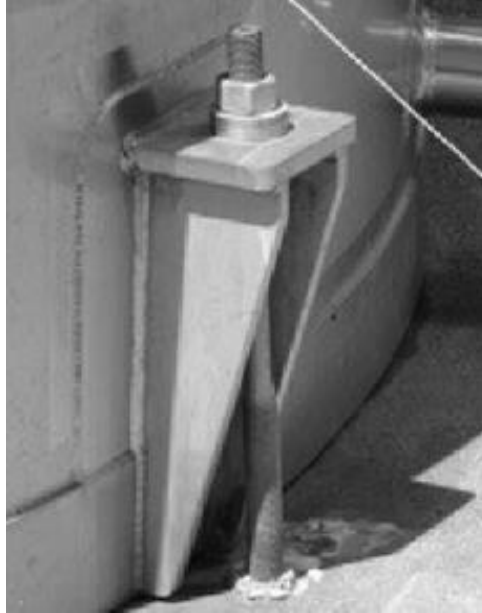
Şekil 17. Ankraj cıvatası
