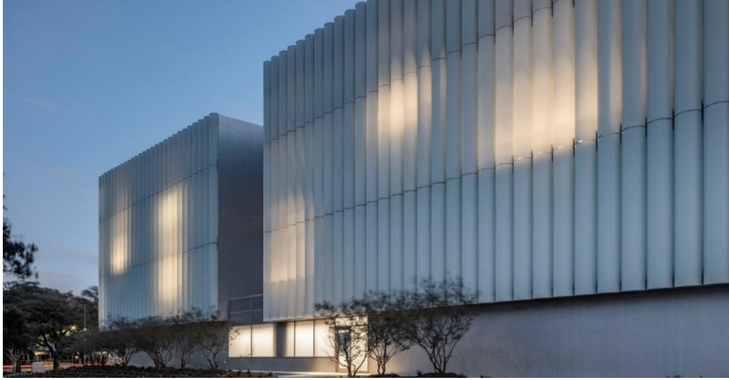
Şekil 79 Hapsedilmiş Işık Algısı Yaratın ve Havalandırma Sağlayan Cam Tüpler [Barnes, 2020]
