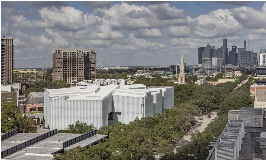
Şekil 80 İkonik Yapılarla Çevrili Müze Binası [Barnes, 2020]
