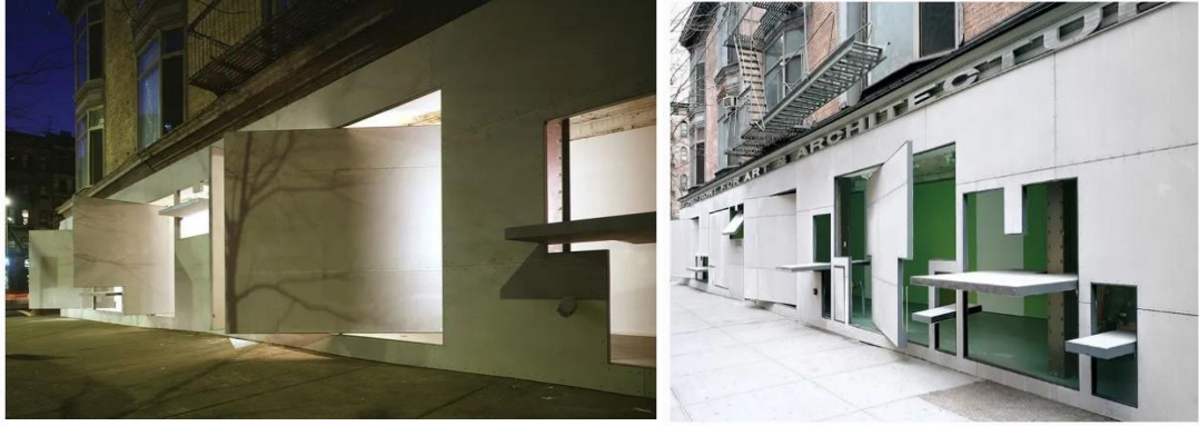
Şekil 37 Yapının Genişlemesini Sağlayan Döner Paneller [Bianchini, 2021]
