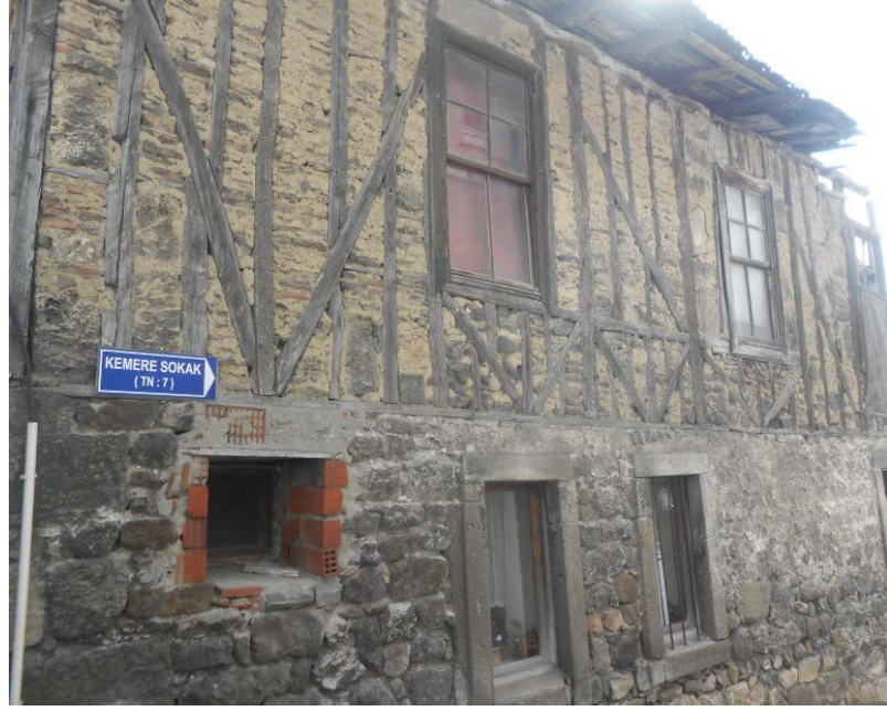
Şekil 3. 33: Ahşap karkas arası kerpiç dolgu tekniği
