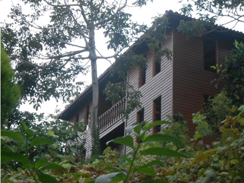
Şekil 4.10: Arka cephedeki balkon görünümü
