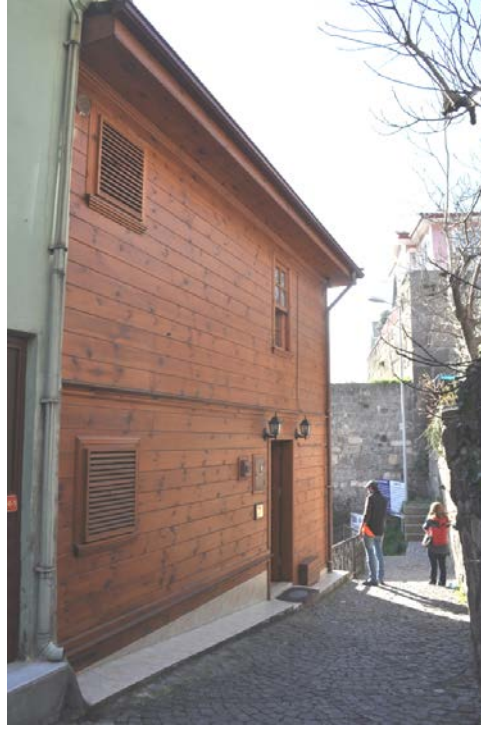
Şekil 4. 86: Evin giriş kapısının olduğu arka cephe görünümü
