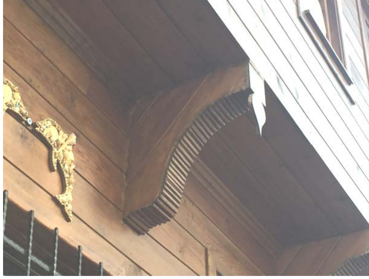
Şekil 3.48: Kum oteldeki çıkma altı payanda süslemesi
