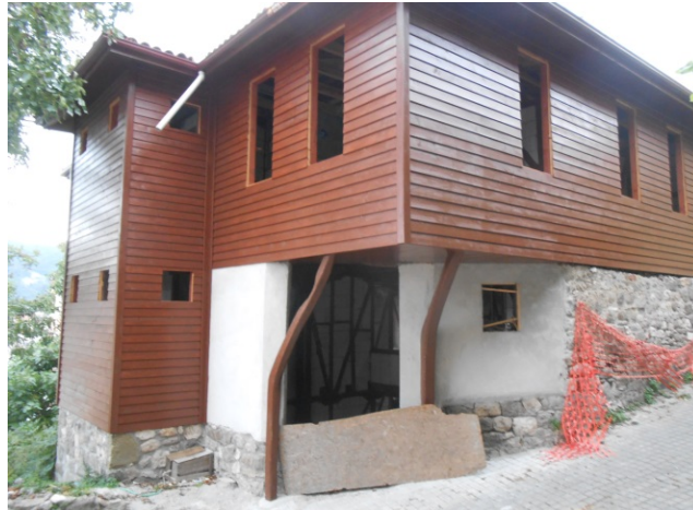
Şekil 4.2: Evin giriş cephesinden görünümü
