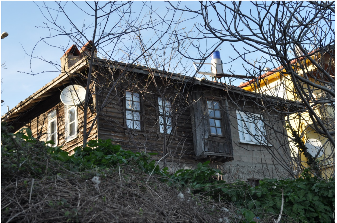
Şekil 4. 36: Yarısi geleneksel ahşap karkas yarısi tuğla biriket kalan evin arka cephesi
