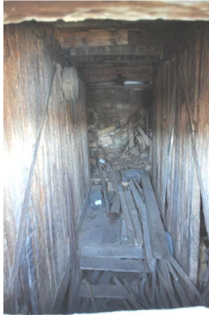
Şekil 4. 27: Kulluğun giriş holü
