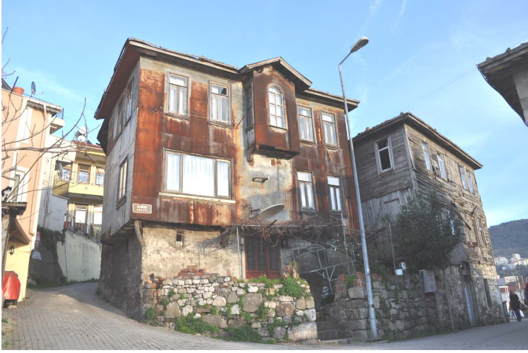
Şekil.4.100: Giriş cephesi görünümü
