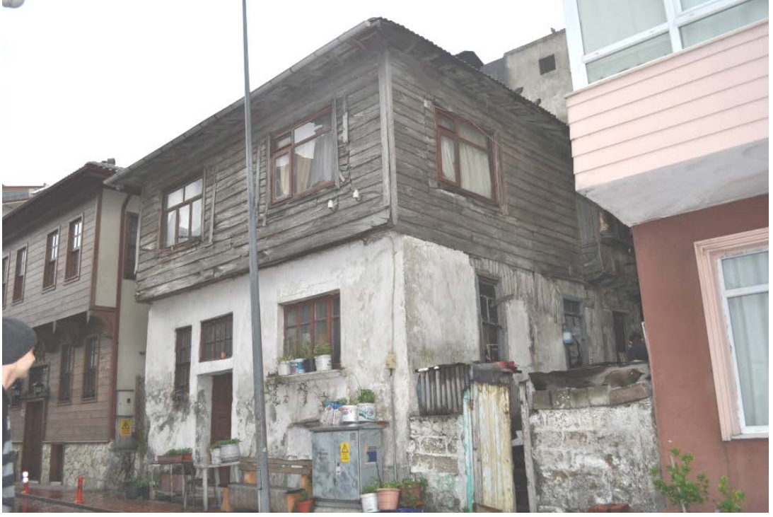
Şekil 4. 121: Postacı Mehmetlerin evi yol cehpesi görünümü
