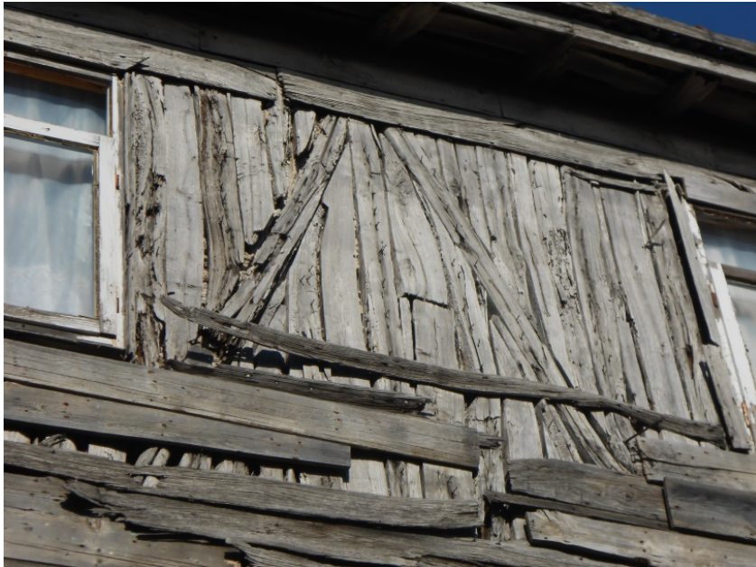
Şekil 4. 60: Evin ahşap dolgu duvarları
