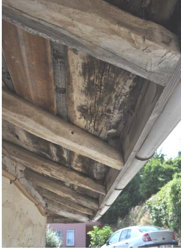
Şekil 3.39 Bölgedeki evlerden bir çatının saçak altı
