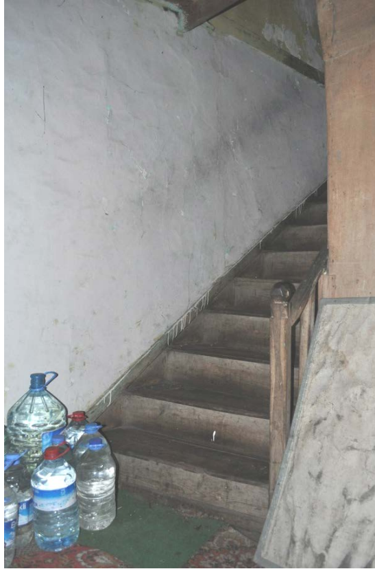
Şekil 4. 125: Kulluktan birinci kata çıkış merdivenleri
