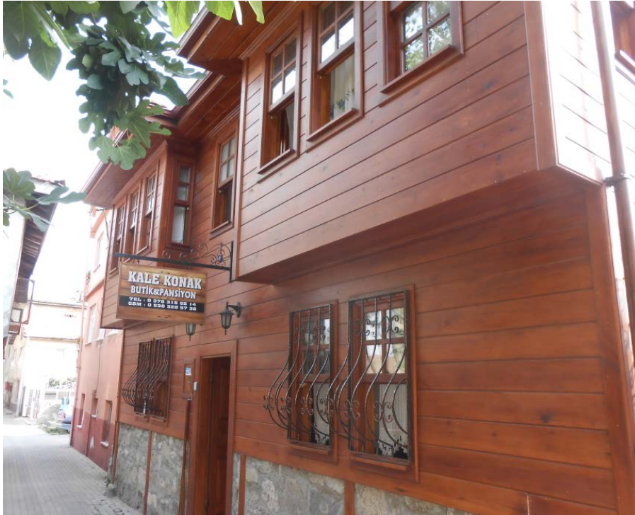
Şekil 4. 87: Giriş cephesi görünümü
