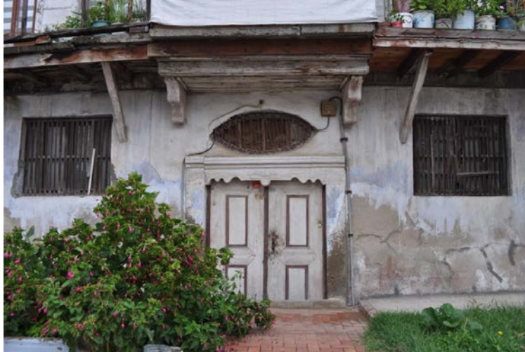
Şekil 4.67: Evin giriş kapısı yani kulluğa açılan kapı
