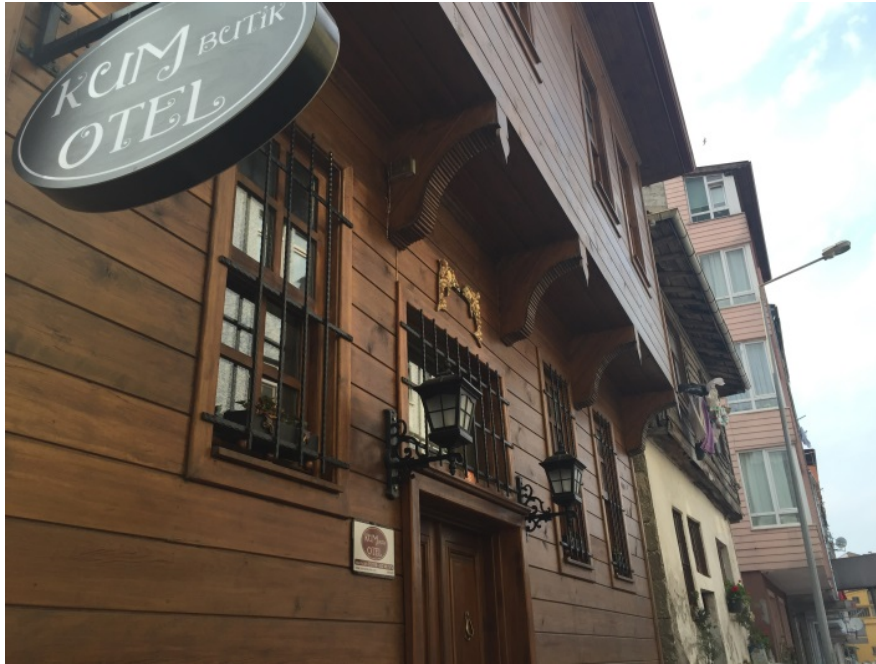
Şekil 4. 22: Konsol çıkmanın altındaki eliböğründeler
