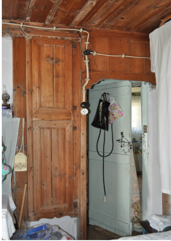
Şekil 4. 32: Ocağın yanındaki yüklük dolabı ve oda kapısı
