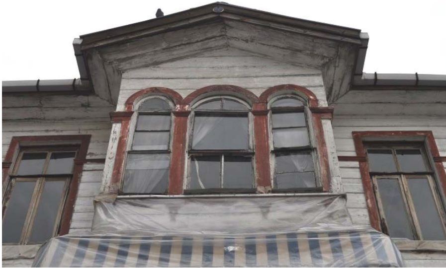
Şekil 4. 74: Cumba üzerindeki yuvarlak hatlı pencereler
