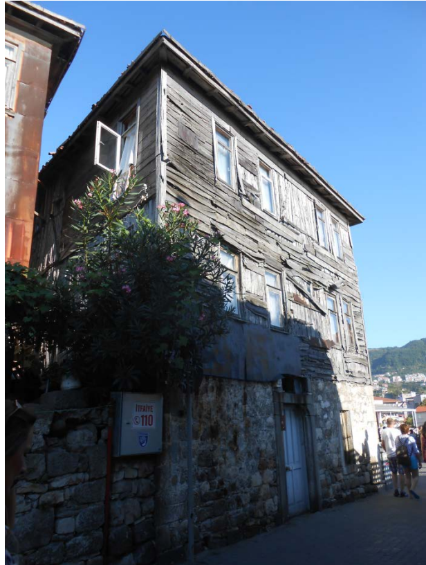
Şekil 4.55: Sertellerin evi sokak üzerindeki kulluk kapısı
