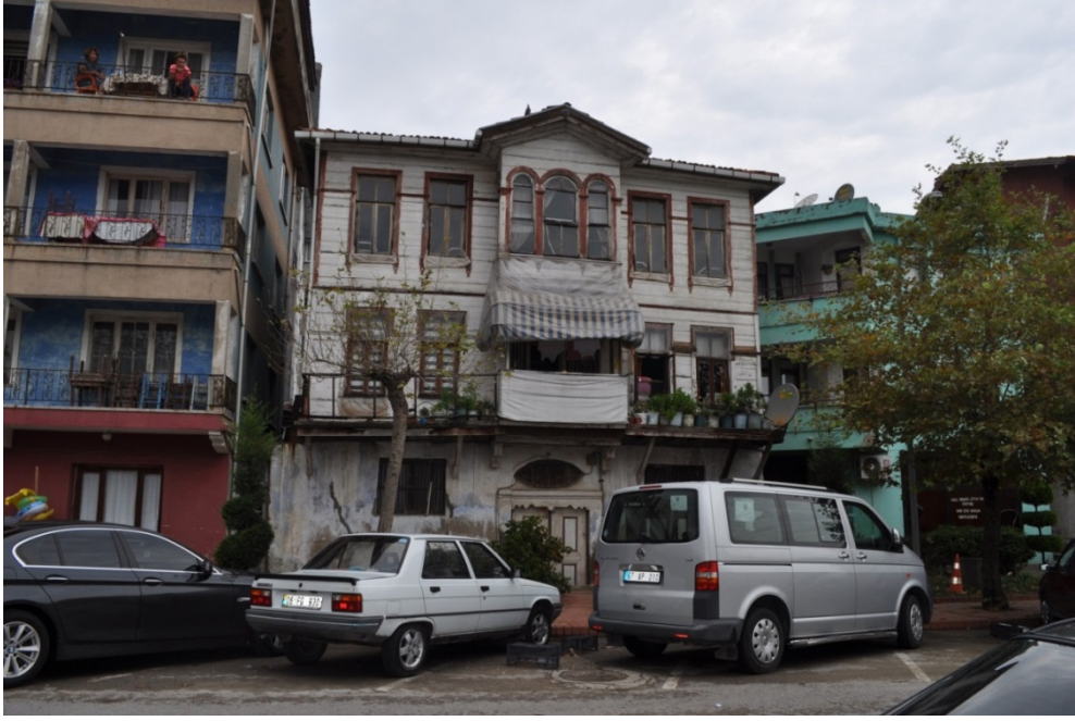
Şekil 4. 63: Giriş cephesi görünümü
