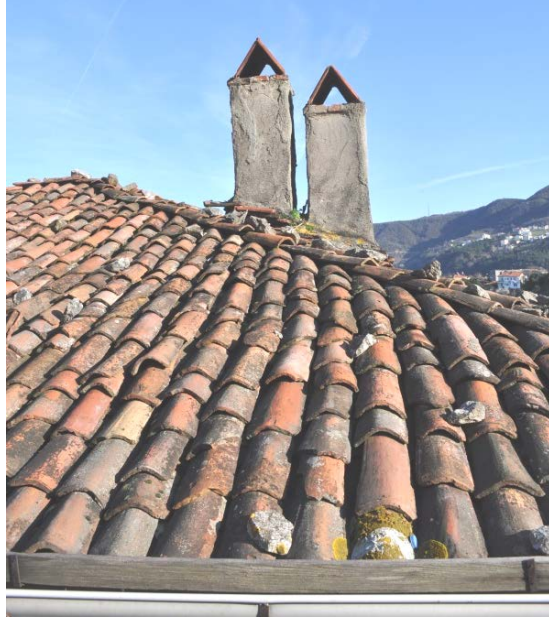
Şekil 3. 38 Geleneksel alaturka kiremit çatı örtüsü örneği
