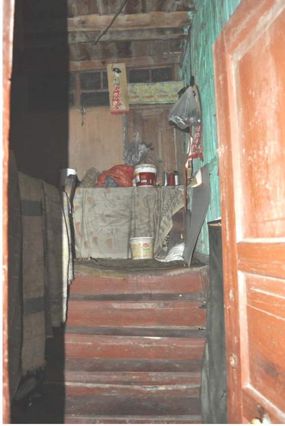
Şekil 4. 124: Evin giriş kapısı ve kulluğa çıkış merdivenleri
