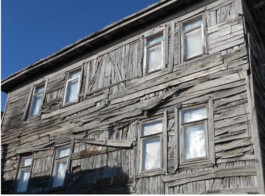
Şekil 3. 32 Ahşap karkas arası ahşap dolgu tekniği
