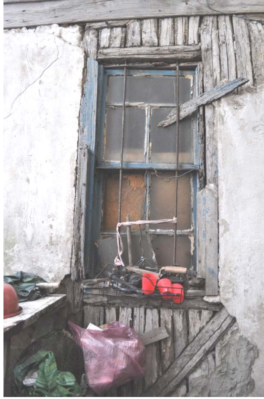
Şekil 4. 134: Demir parmaklıklı kulluk penceresi
