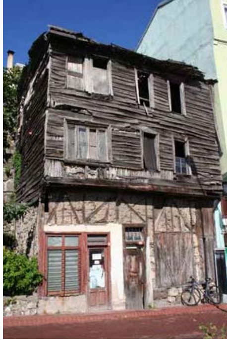
Şekil 3. 34 Amasra’da zemin katın kerpiç dolgu tekniğiyle yapıldığı bir ev örneği (Yaylı, A., Ozan, Y., Boran, H. 2011)
