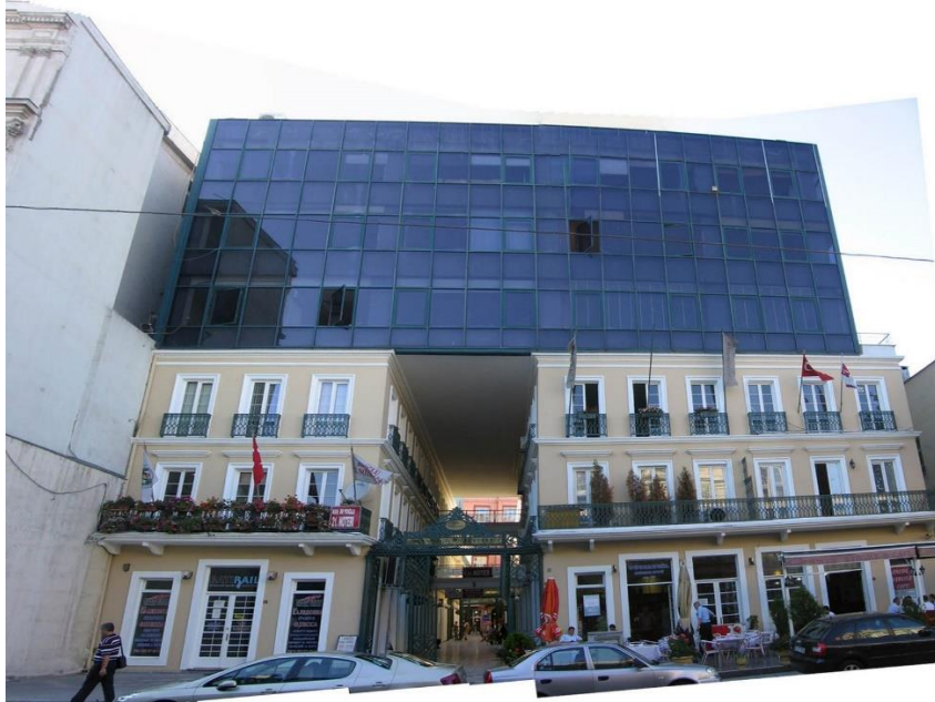
Şekil 51. Fransız Geçici Restorasyon Sonrası Çağdaş Ek
