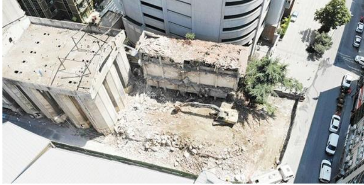
Şekil 129. Yıkımı Gerçekleştirilen Ek Yapılar
