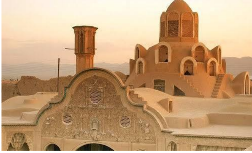
Şekil 51 İran Kashan Boroujerdi Malikanesi Rüzgar Kulesi Örneği
