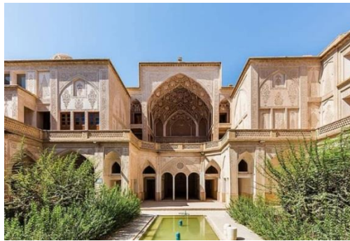
Şekil 74 Kashan Abbasian Evinde Rüzgar Kapanı Örneği
