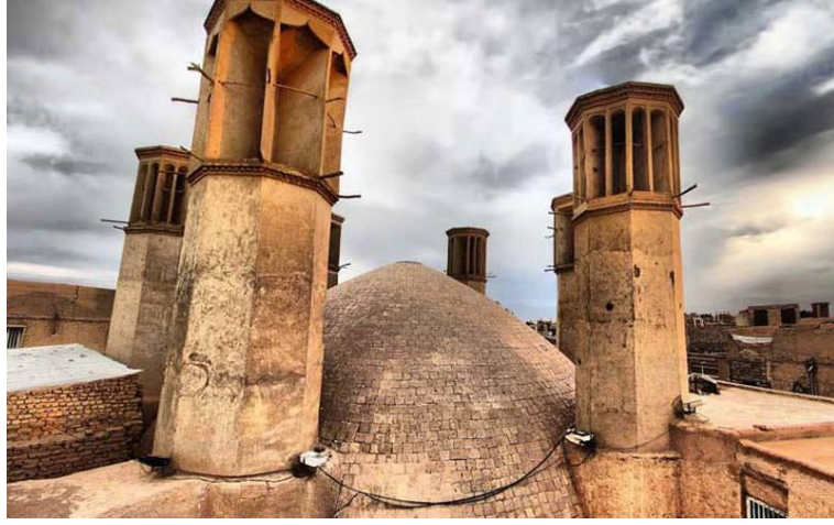
Şekil 65 Yazd Şehrinde Su Deposu Badgir Örneği
