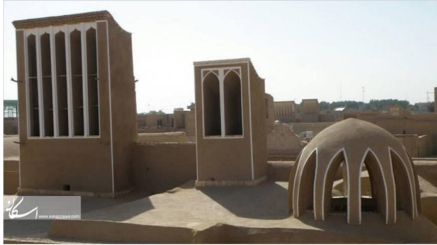
Şekil 38 Ardakani Rüzgar Kulesi Örneği
