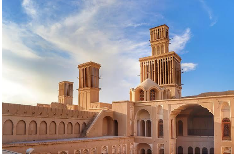
Şekil 2 Rüzgar Kulesi Örneği(Tabatabayi Konağının rüzgar kulesi-kashan-Iran)
