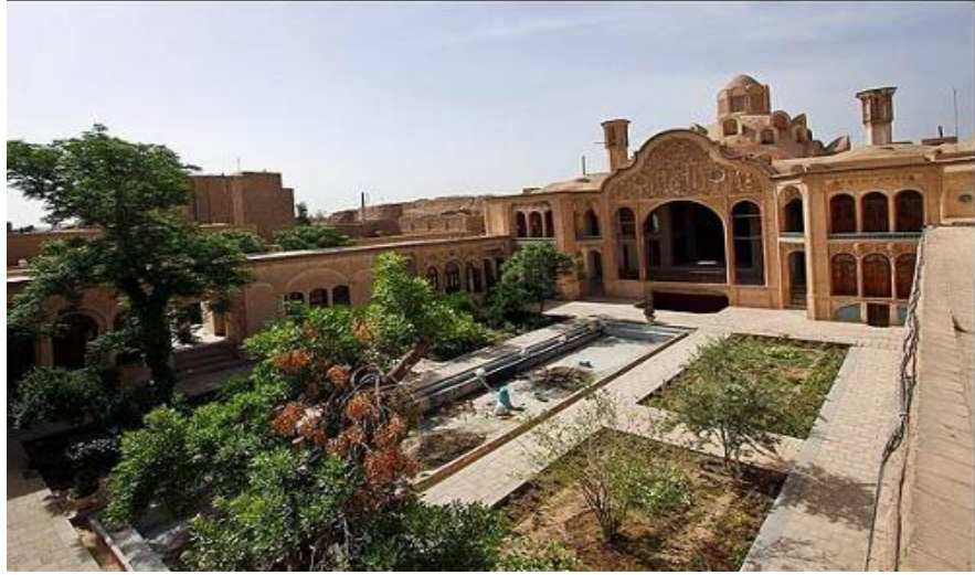
Şekil 52 İran Kashan Boroujerdi Malikanesi Rüzgar Kulesi Örneği
