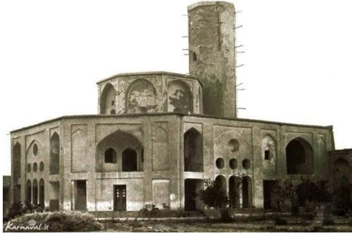
Şekil 57 Dolat Abad Rüzgar Kulesi Örneği
