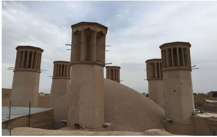
Şekil 66 Yazd Şehrinde Su Deposu Badgir Örneği
