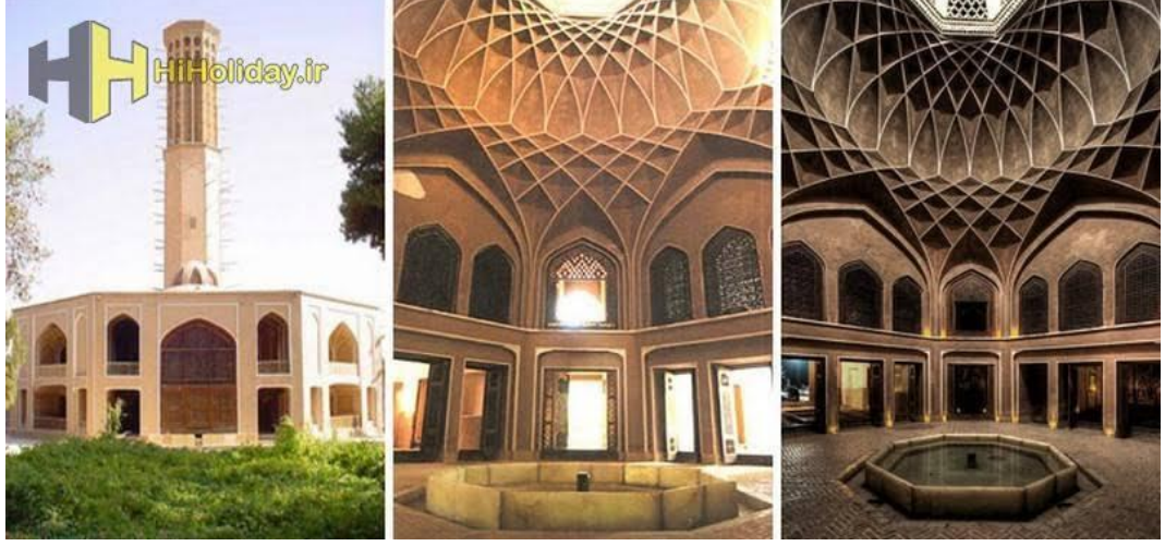
Şekil 55 Dolat Abad Rüzgar Kulesi Örneği
